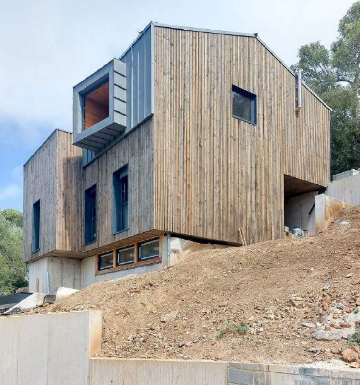
Vivienda unifamiliar aislada. Les Planes.
